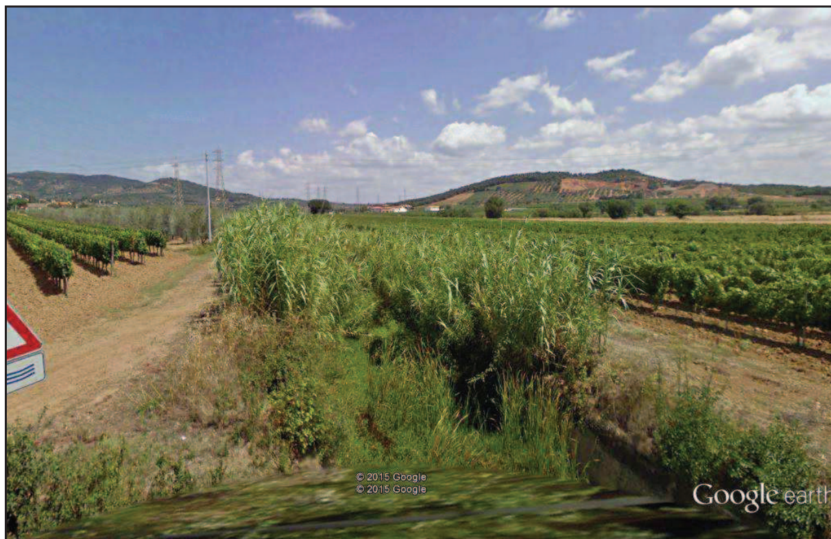
Figura 3: foto dell'alveo di monte del Fosso Notro dal ponte della S.P. n.22 dei Forni.
