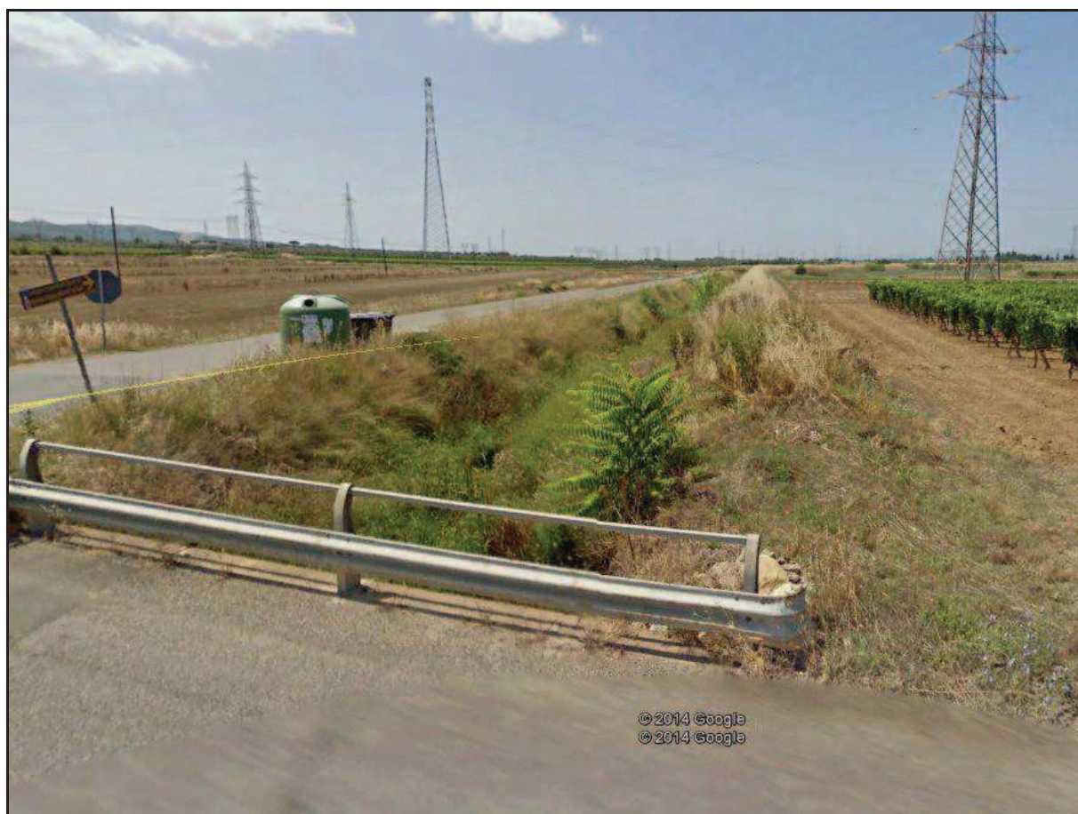
Figura 4: foto dell'alveo di valle del Fosso Notro dal ponte della S.P. n.22 dei Forni.
